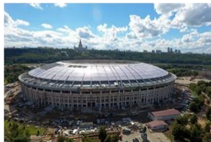
Реконструкция БСА Лужники
